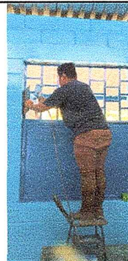
Foto 4: Sustitucion de balcones.
