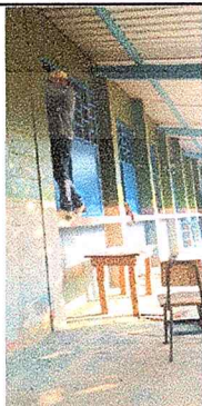
Foto 5: Pintura de exterior de aulas.
