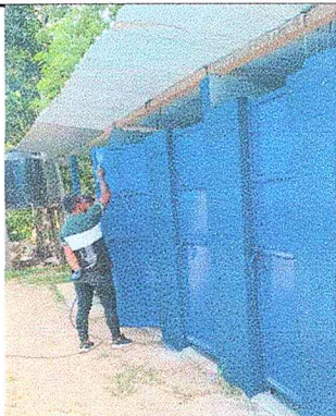
Foto 1: Pintura de puertas de baños.
