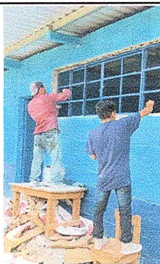
Foto 3: Sustitución de balcones en aulas debido a mala ventilación.
