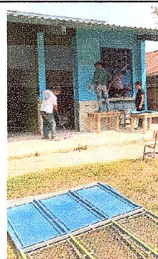
Foto 6: Sustitución de puertas en aulas debido a mal estado.
